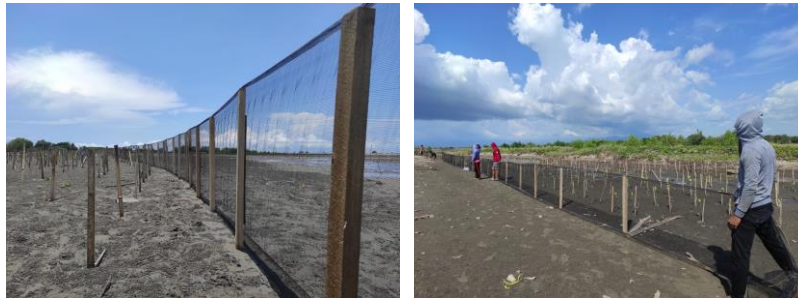
(Gambar 7. Pemasangan Pelindung Kawasan di Desa Bababinanga)
