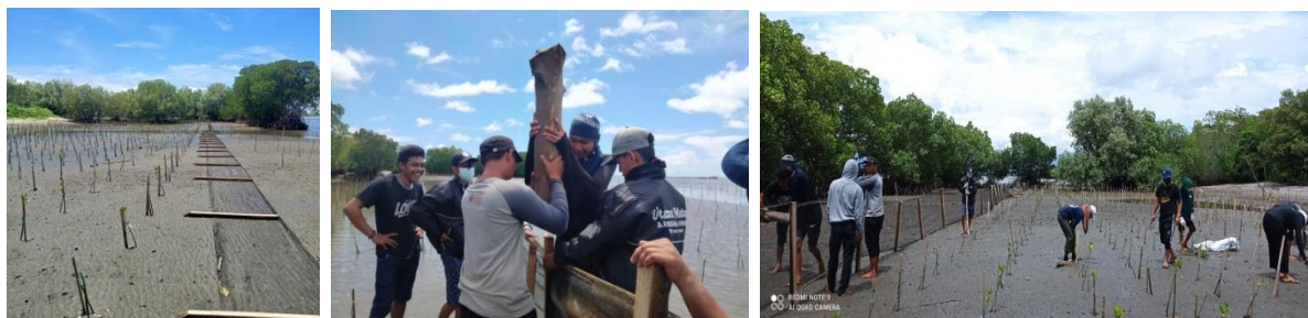
(Dokumentasi Perbaikan Pelindung Kawasan Penanaman yang Rusak)
