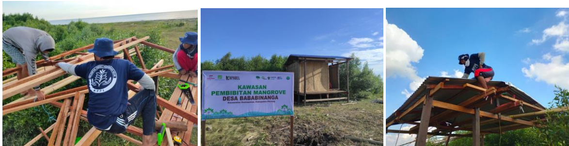
(Gambar 16. Pembangunan Rumah Bibit Mangrove)
